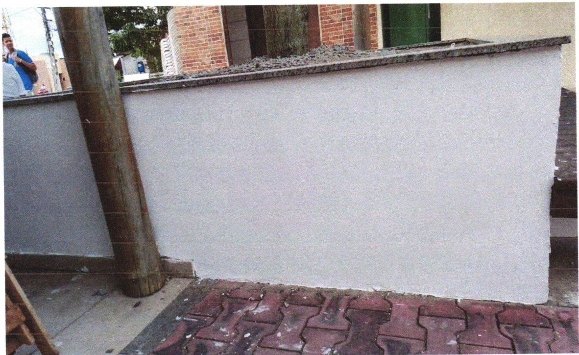
FOTO 06 - EMASSAMENTO DE PAREDES DO CANTEIRO.
