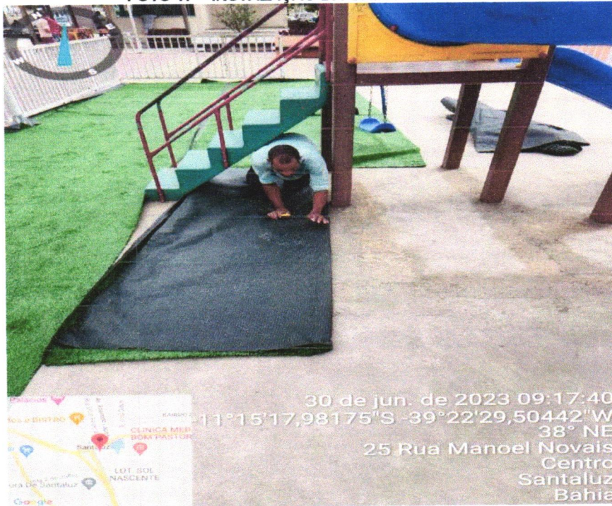
FOTO 17 – INSTALAÇÃO DA GRAMA SINTÉTICA.
