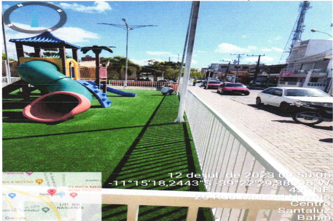
FOTO 25- PINTURA DA ESTRUTURA METÁLICA E FORNECIMENTO E INSTALAÇÃO DE GRAMA SINTÉTICA
