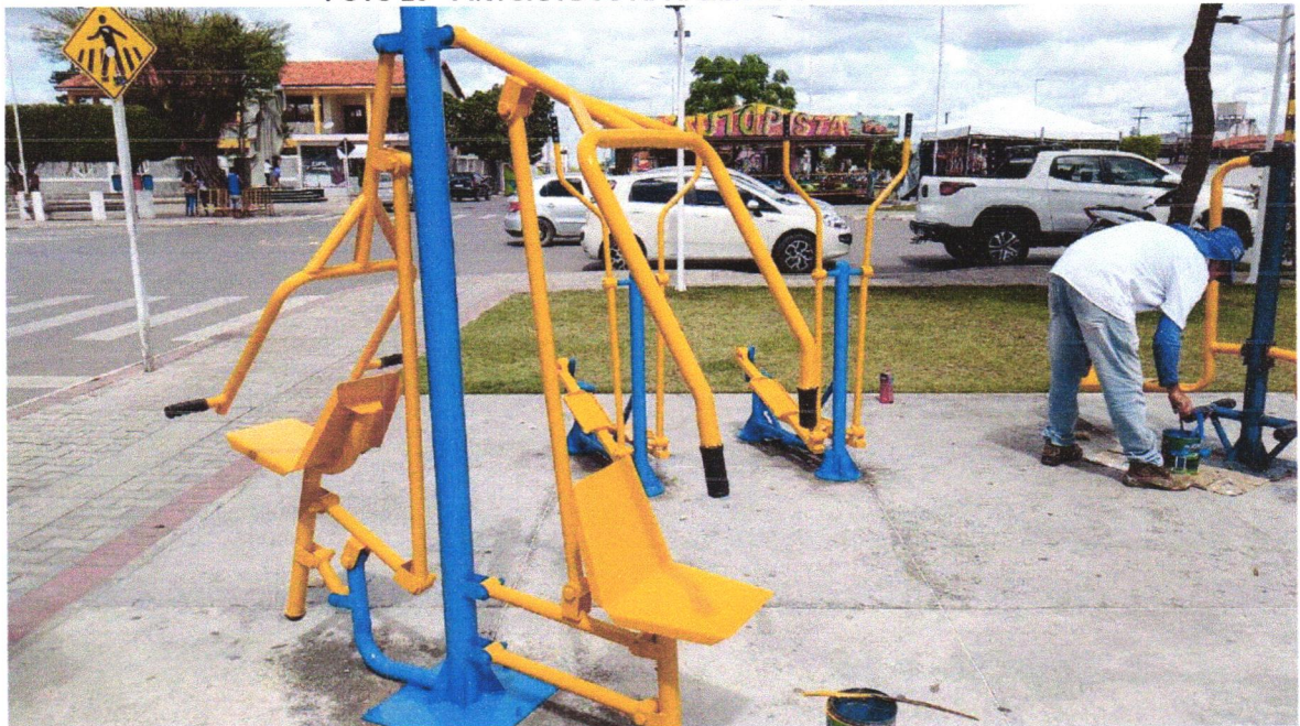
FOTO 20 - PINTURA DOS APARELHOS DE GINÁSTICA
