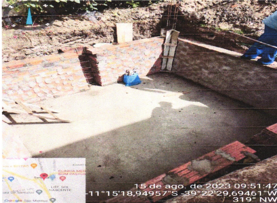
FOTO 30– REBOCO IMPERMEABILIZADO DAS PAREDES DO RESERVATÓRIO E DESFORMADA DAS VIGAS PARA APOIAR A LAJE
