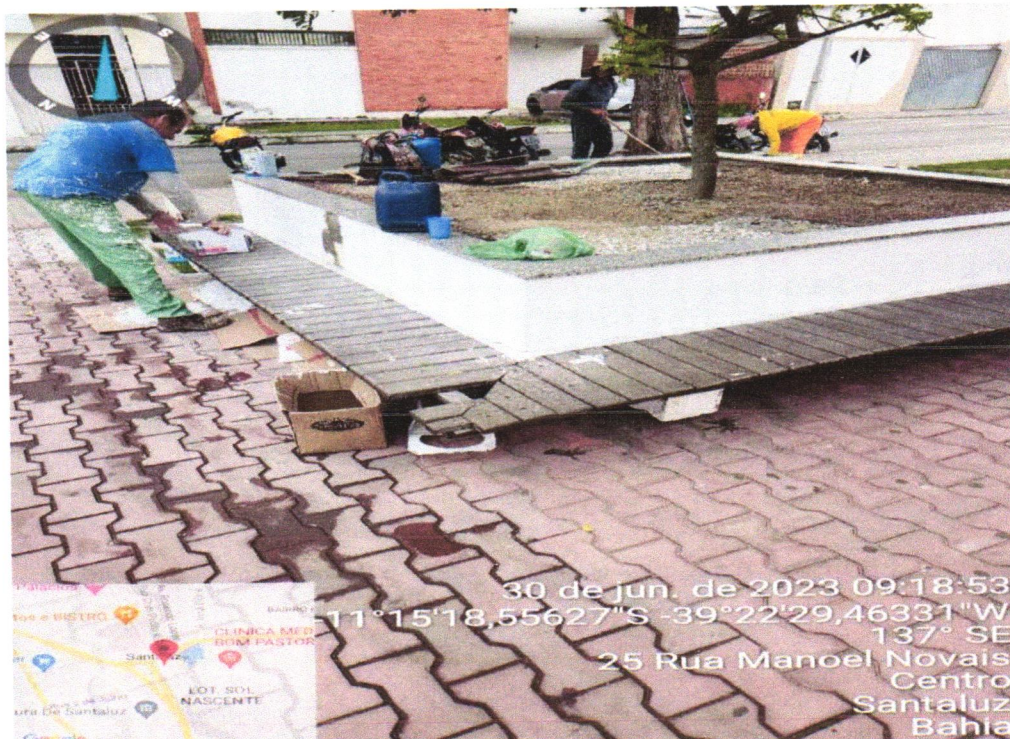
FOTO 08 - EMASSAMENTO DE PAREDES DO CANTEIRO.
