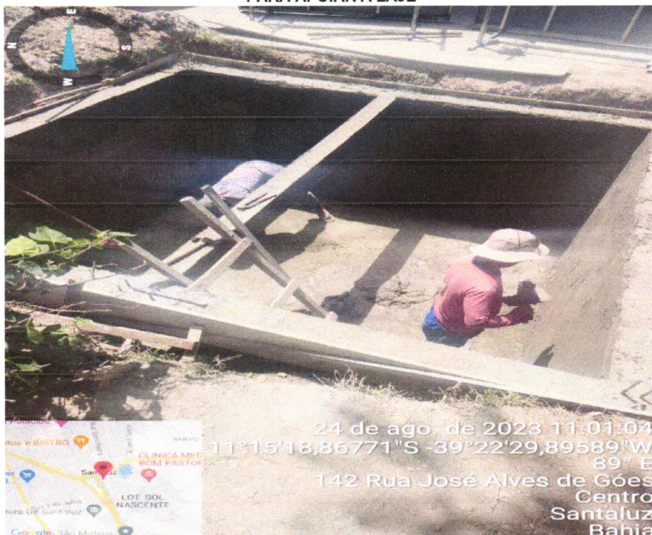
FOTO 30– REBOCO IMPERMEABILIZADO DAS PAREDES DO RESERVATÓRIO E DESFORMADA DAS VIGAS PARA APOIAR A LAJE
