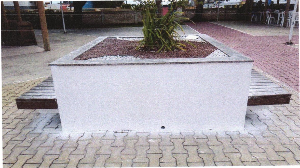
FOTO 07 - EMASSAMENTO DE PAREDES DO CANTEIRO.
