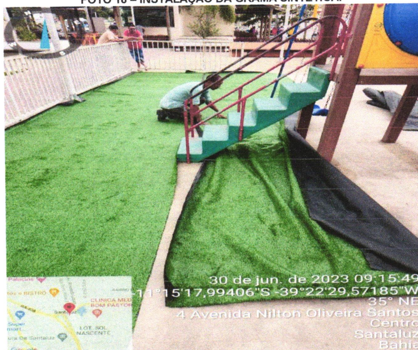
FOTO 18 – INSTALAÇÃO DA GRAMA SINTÉTICA.
