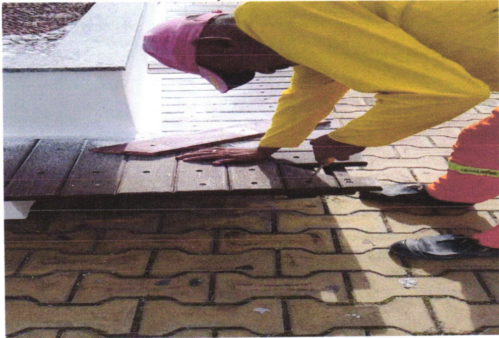
FOTO 10 - REPARAÇÃO DOS BANCOS DE MADEIRA
