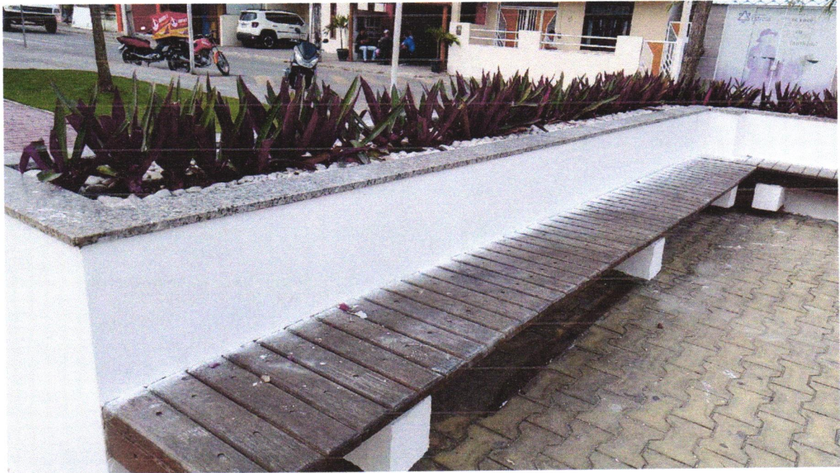
FOTO 05 – EMASSAMENTO DE PAREDES DO CANTEIRO.
