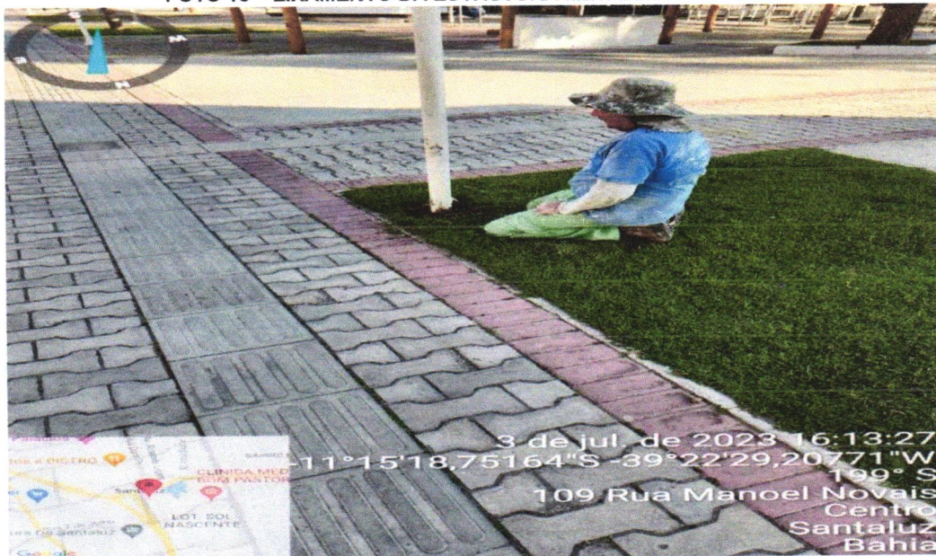
FOTO 13 – LIXAMENTO DA ESTRUTURA METÁLICA DO POSTE
