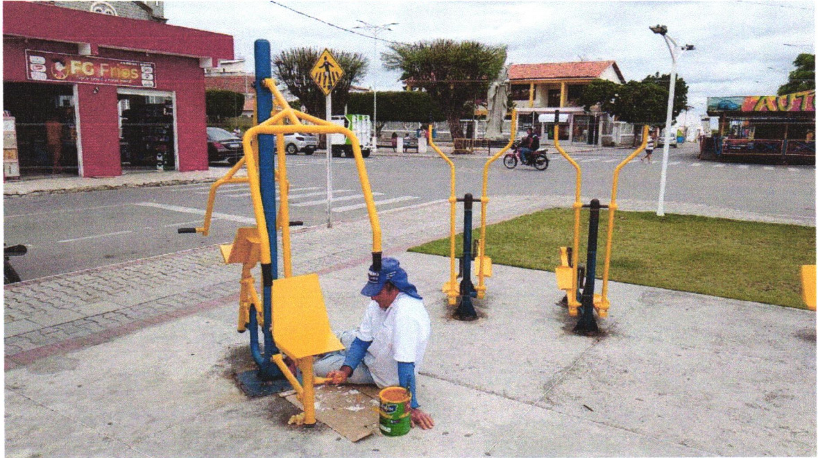
FOTO 19 – PINTURA DOS APARELHOS DE GINÁSTICA
