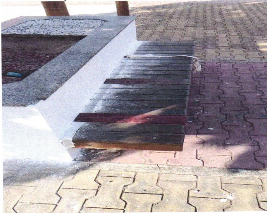
FOTO 11 – REPARAÇÃO DOS BANCOS DE MADEIRA E EMASSAMENTO DA PAREDE
