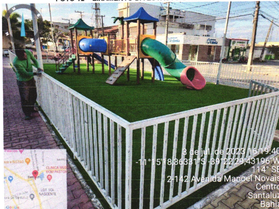
FOTO 12 – LIXAMENTO DA ESTRUTURA METÁLICA
