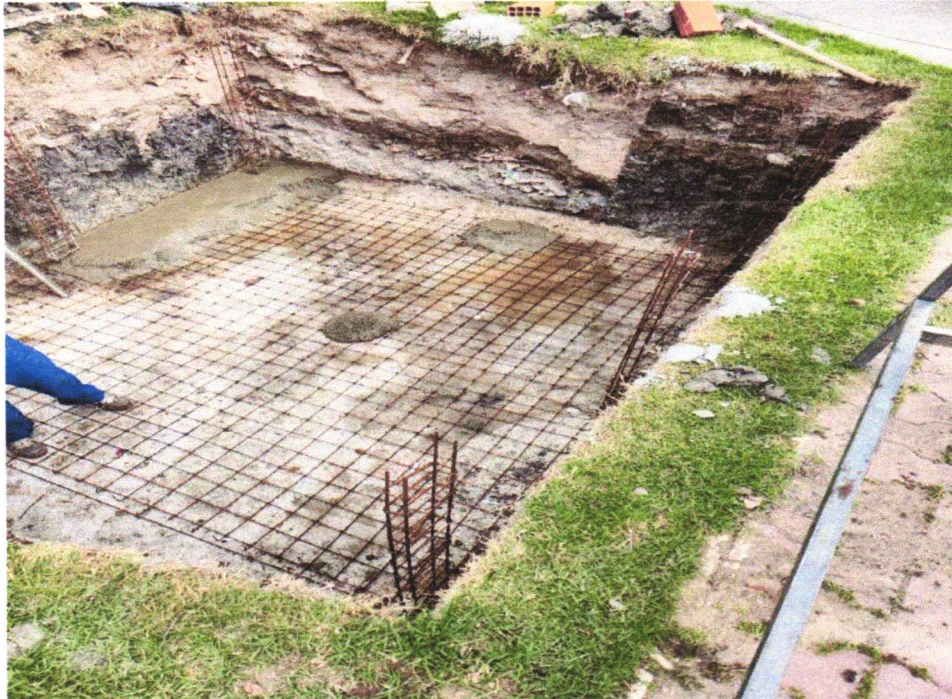
FOTO 36- EXECUÇÃO DO SEGUNDO RESERVATÓRIO
