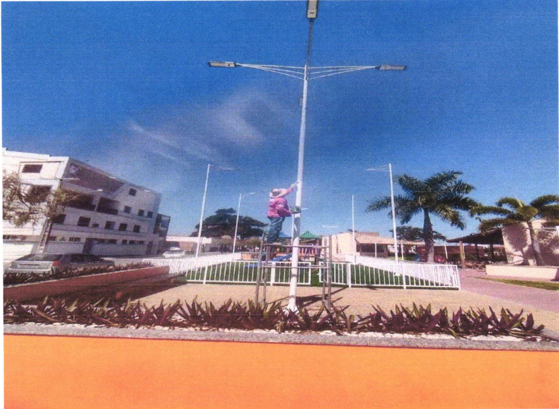
FOTO 33- PINTURA DO POSTE
