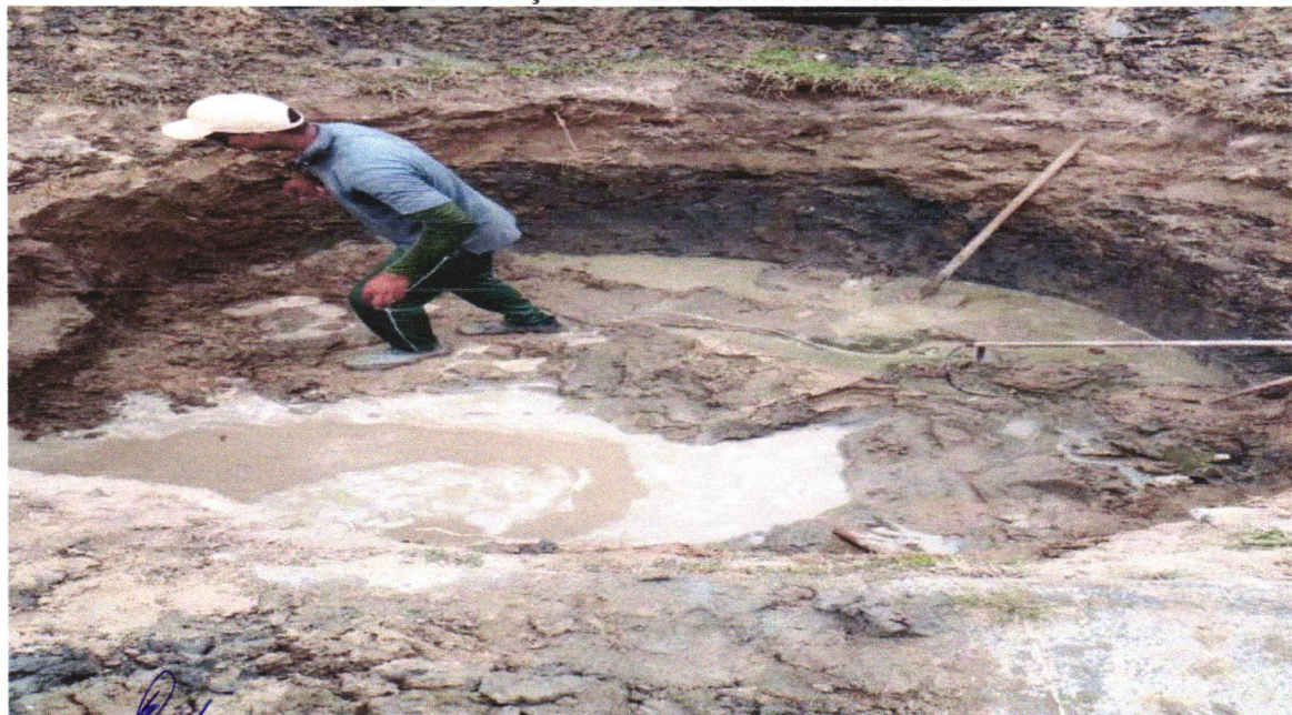
FOTO 26- ESCAVAÇÃO DO RESERVATÓRIO ENTERRADO
